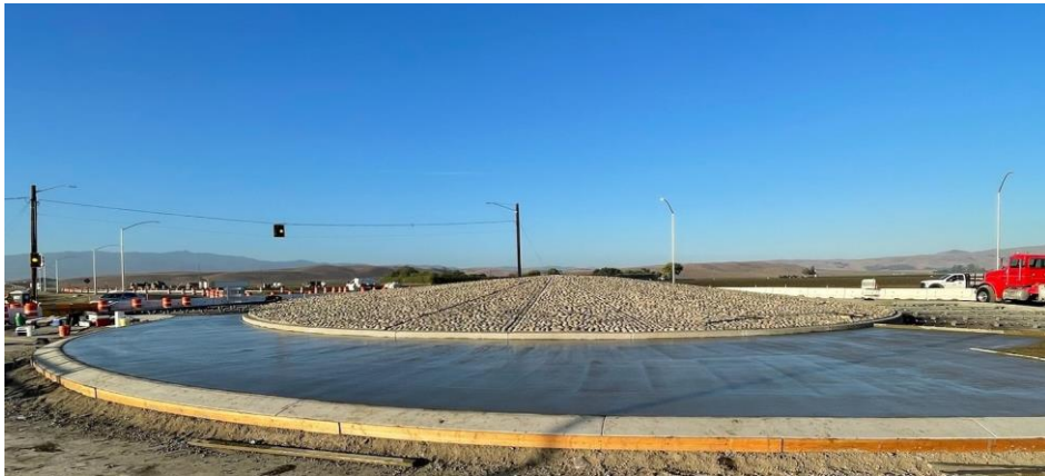
Construcción de la rotonda SR 156/25 Turbo
