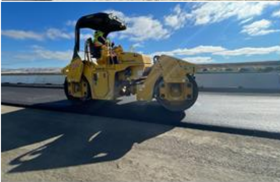
Construcción en SR 156/25 Turbo Rotonda
